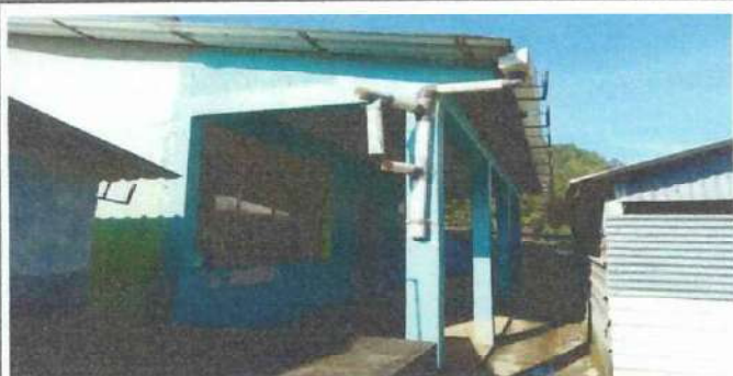
Foto 5: Presencia de humedad avanzada en pared, desprendimiento de canales en el modulo 2.
