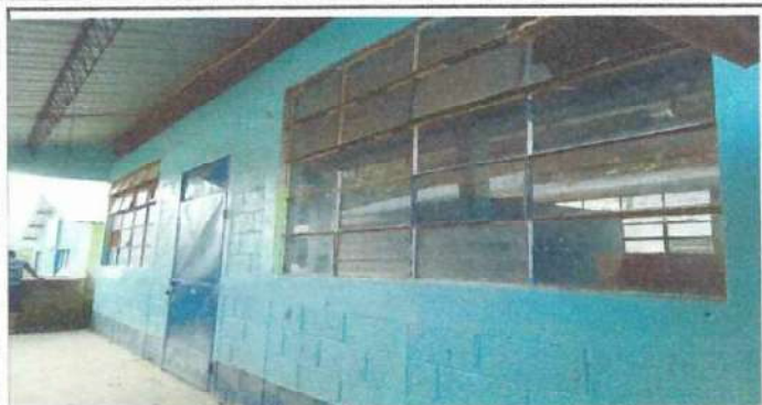
Foto1: Se observa el deterioro de la estructura, desprendimiento pintura en las paredes en el modulo 1 Y 2.
